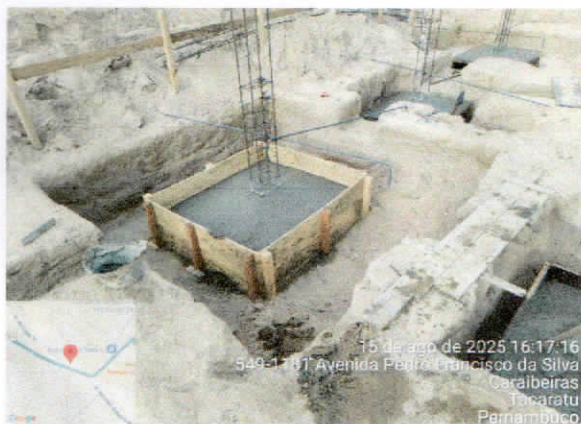
DESCRIÇÃO: CONCRETAGEM DE BLOCO DE COROAMENTO OU VIGA BALDRA DESCRIÇÃO: CONCRETAGEM DE BLOCO DE COROAMENTO OU VIGA BALDRA
