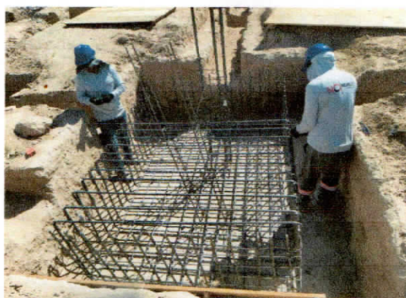
DESCRIÇÃO: CONCRETAGEM DE BLOCO DE COROAMENTO OU VIGA BALDRA DESCRIÇÃO: CONCRETAGEM DE BLOCO DE COROAMENTO OU VIGA BALDRA
