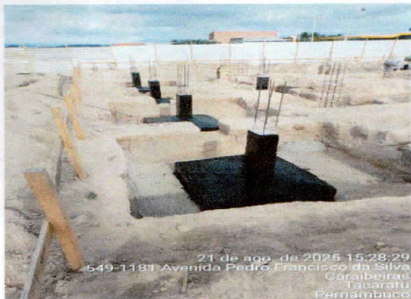
DESCRIÇÃO: IMPERMEABILIZAÇÃO DE SUPERFÍCIE
