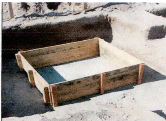
DESCRIÇÃO: CONCRETAGEM DE BLOCO DE COROAMENTO OU VIGA BALDRA DESCRIÇÃO: CONCRETAGEM DE BLOCO DE COROAMENTO OU VIGA BALDRA
