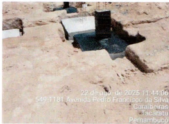
DESCRIÇÃO: CONCRETAGEM DE BLOCO DE COROAMENTO OU VIGA BALDRA DESCRIÇÃO: CONCRETAGEM DE BLOCO DE COROAMENTO OU VIGA BALDRA
