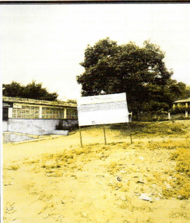
Foto 1: Placa de obra, Sítio Altinho.
